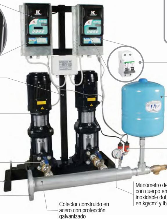
Colector construido en acero con protección galvanizado
